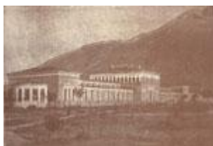
Το πρώτο κτίριο των ιαματικών λουτρών, κτισμένο στα τέλη του 19ου αιώνα, διέθετε σαρανταδύο μαρμάρινους λουτήρες, δύο δεξαμενές ομαδικών λούσεων.
